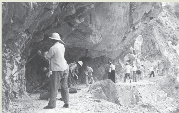
東西橫貫公路工程的施工。
