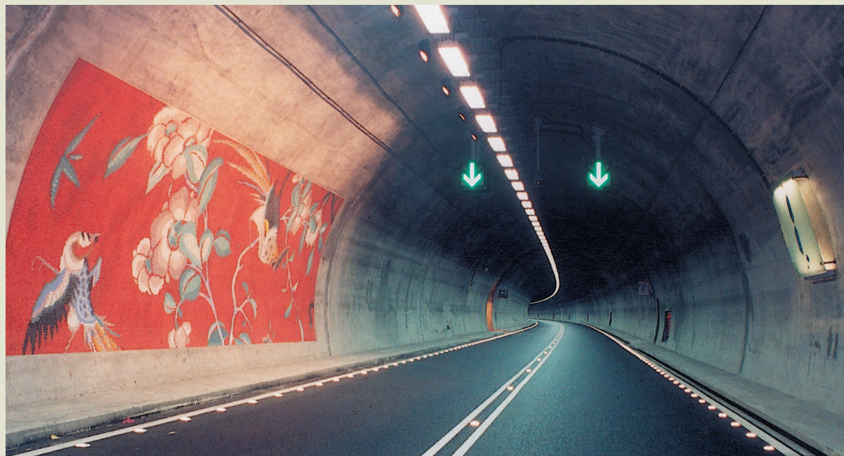
由榮工公司歷經14年艱苦施工完成的雪山隧道一景。
