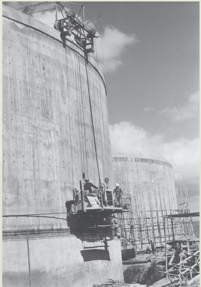
榮工早期半機械化施工，圖為台北五分埔中油油槽工程。
