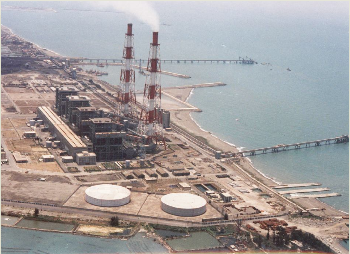
台電興達電廠，榮工從填地開始，進行海上工程的營建。
