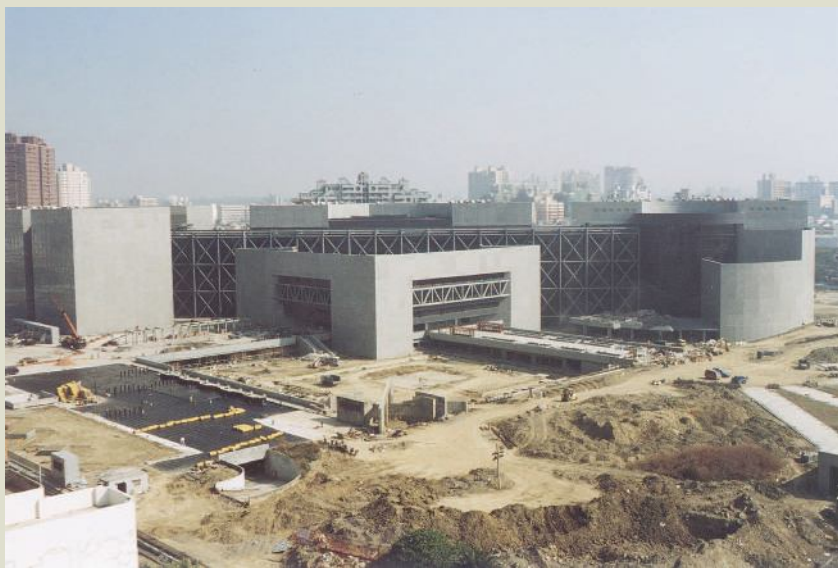
高雄國立科學工藝博物館工程施工。
