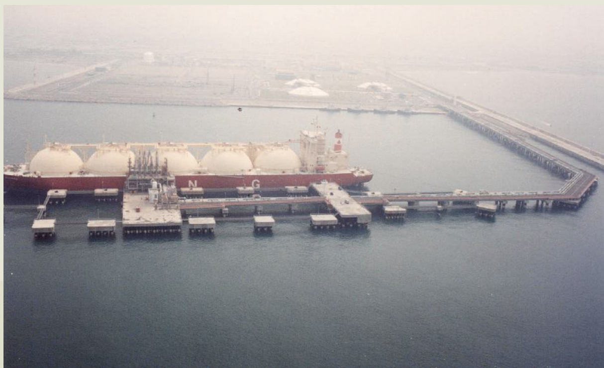
中油液化天然氣港油氣輪停靠卸載。
