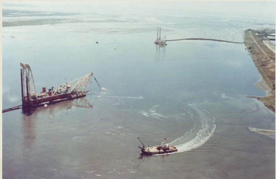
榮工挖泥船團分散在高屏溪出海口，填築林園石化工業區。
