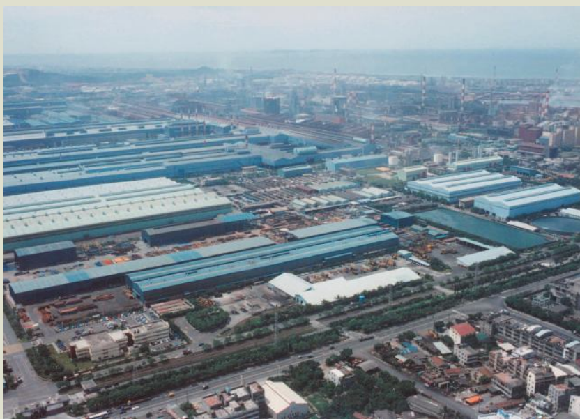
榮工承辦中鋼1期第3階段工程完工後，中鋼已成全球名列前茅之大鋼廠。
