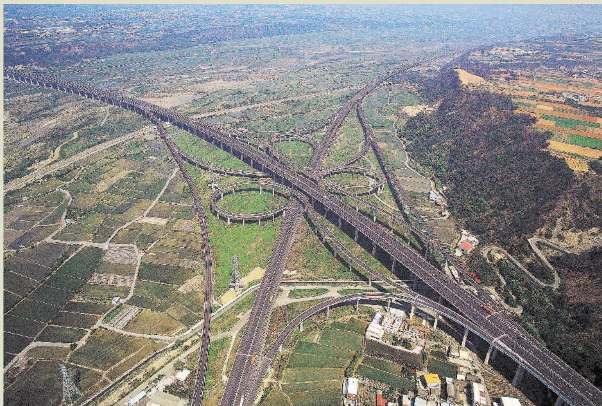
車道盤疊的中二高中港系統交流道。
