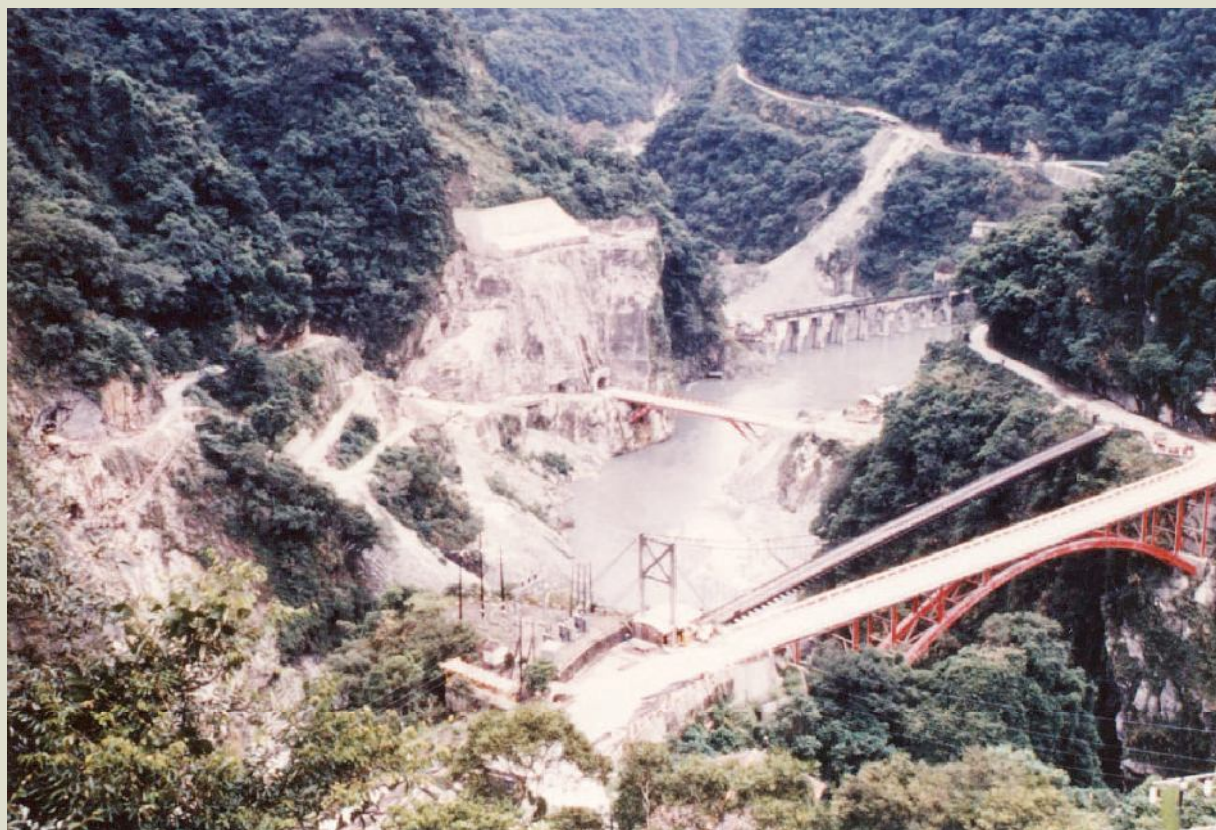
木瓜溪水力發電工程，榮工完成整個流域多座水力電廠。
