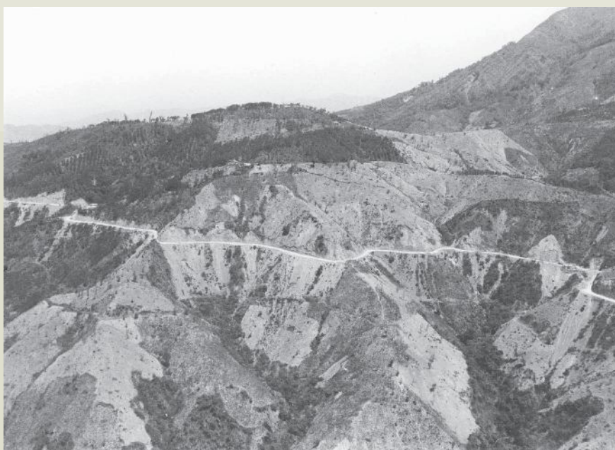
北部橫貫公路施工的艱鉅，不比中部東西橫貫公路遜色。
