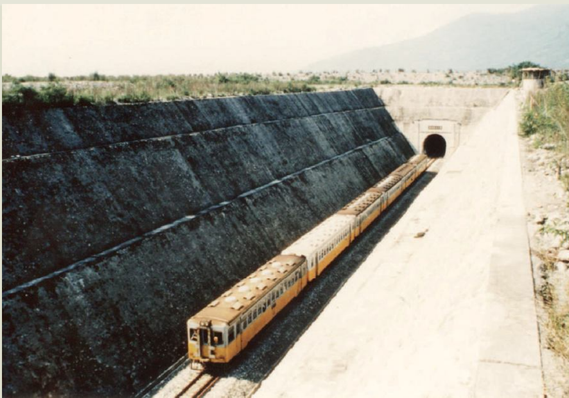
東線鐵路拓寬工程榮工處完成溪口及光復河底隧道，杜絕鐵路橋因河床不斷淤高所產生之行車問題。
