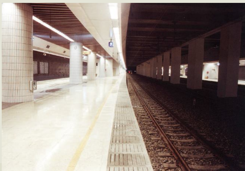
台北市區鐵路地下化台北新站地下層月台。
