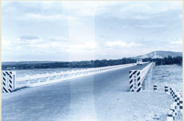
榮工早年施工完成的后豐大橋。
