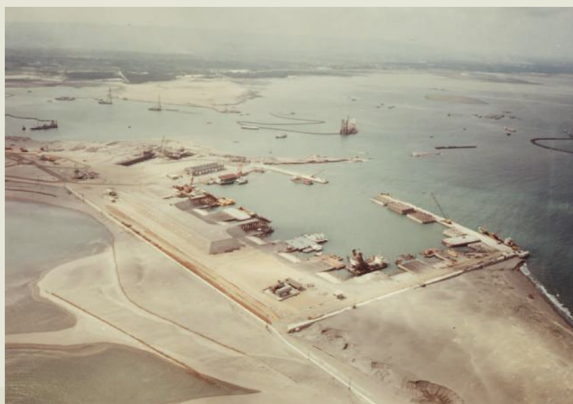
台中港是榮民弟兄從一片沙灘中建設起來的人工港，圖為沉箱渠內的沉箱製作。
