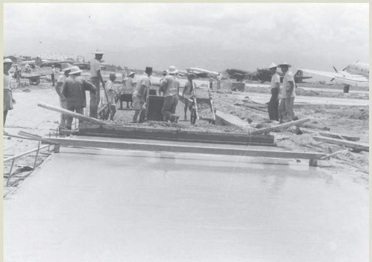
屏東機場工程的人力施工。
