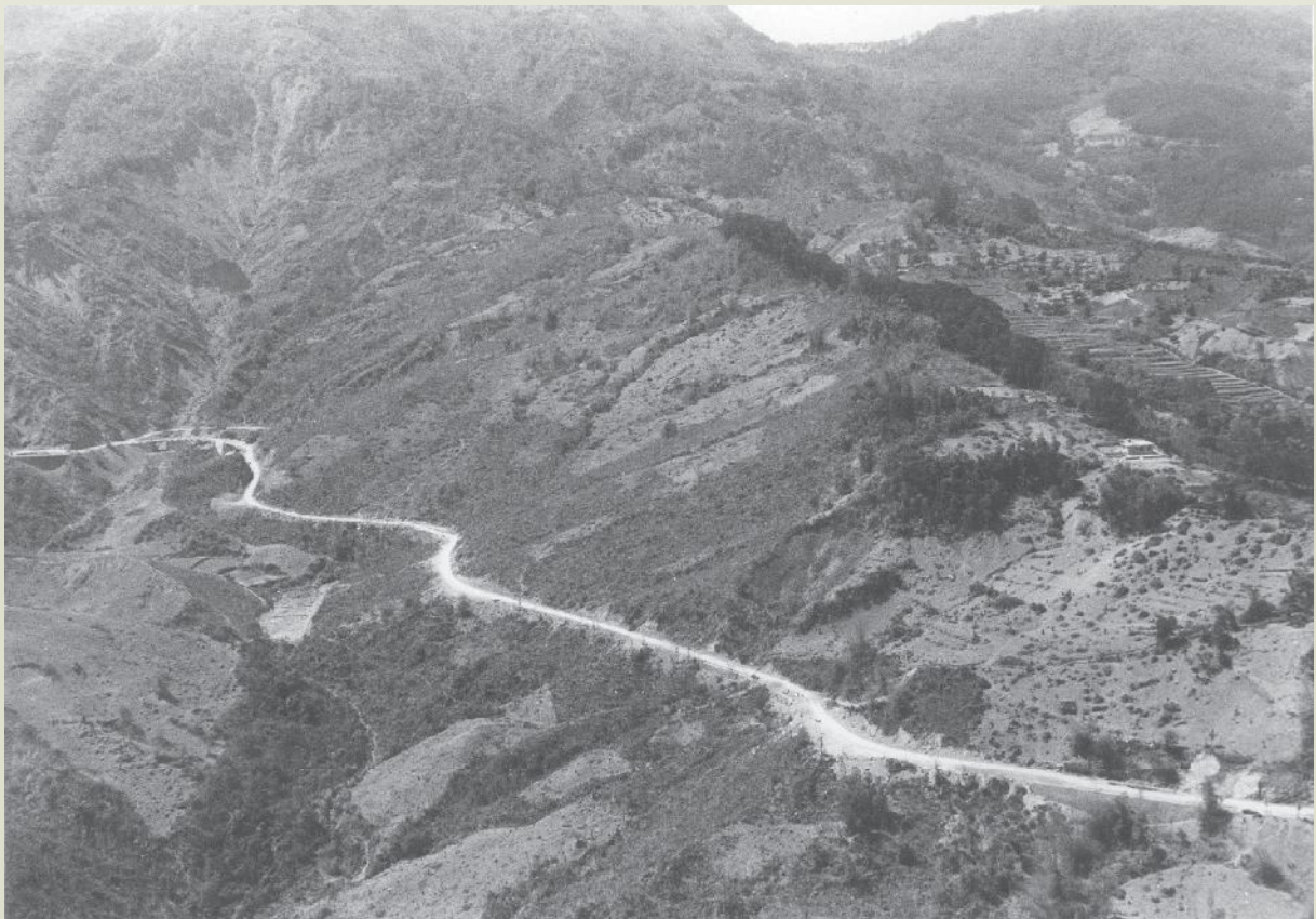
南部橫貫公路工程的施工使用大量機械，比起中橫與北橫的施工進步多了。
