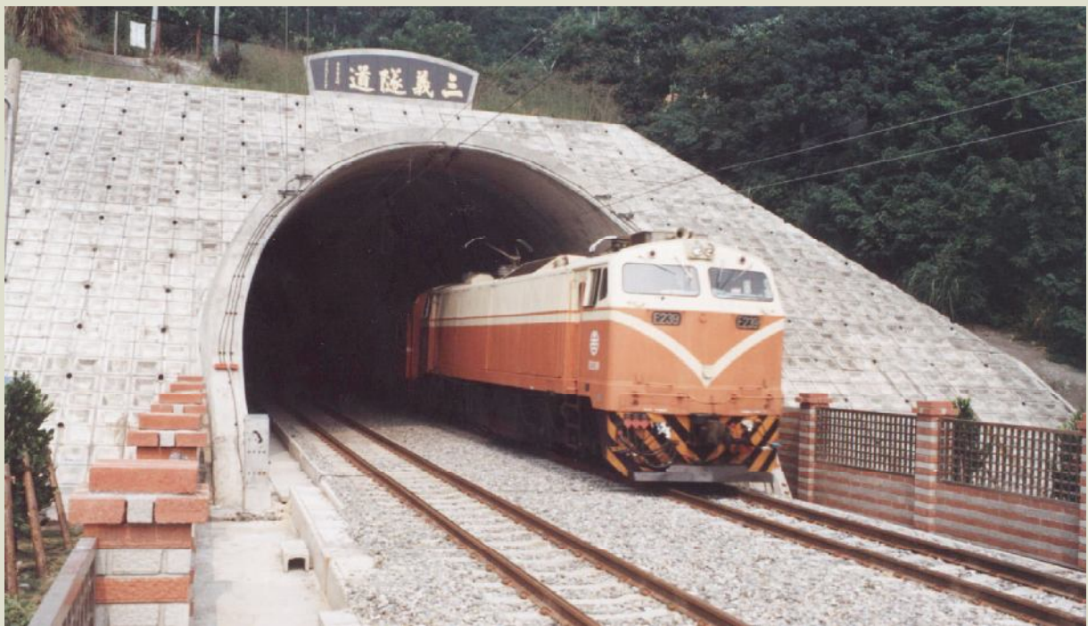
鐵路西部幹線三義隧道完工通車。
