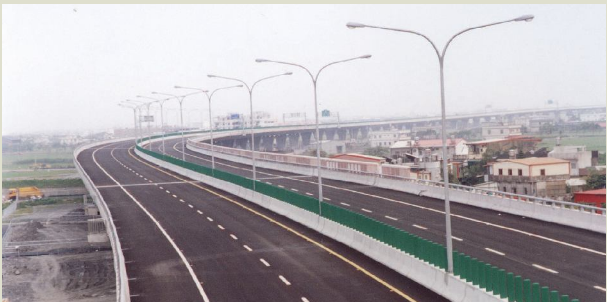
北宜高速公路頭城屋蘇澳段工程。
