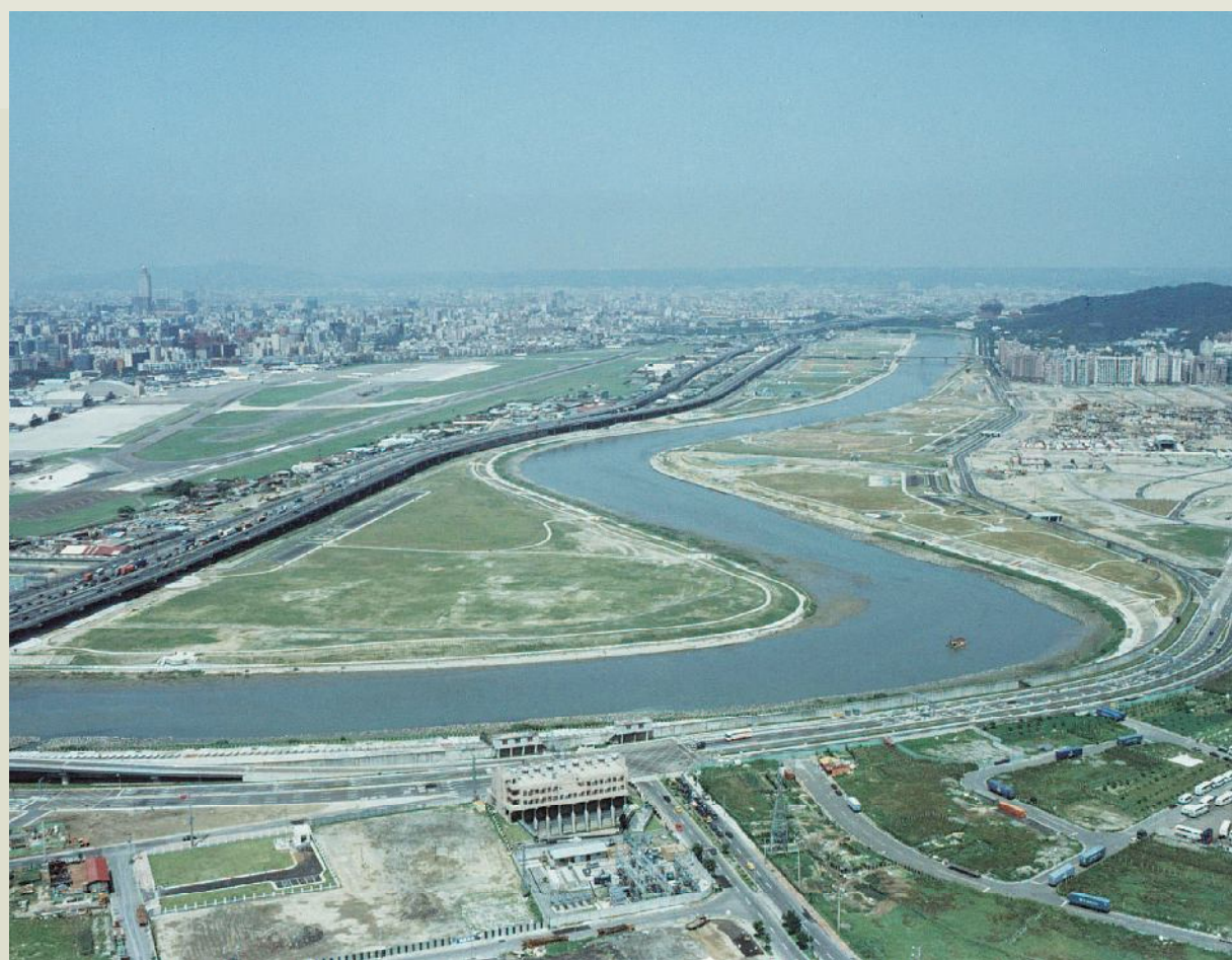
完成整治後之基隆河內湖大直段。
