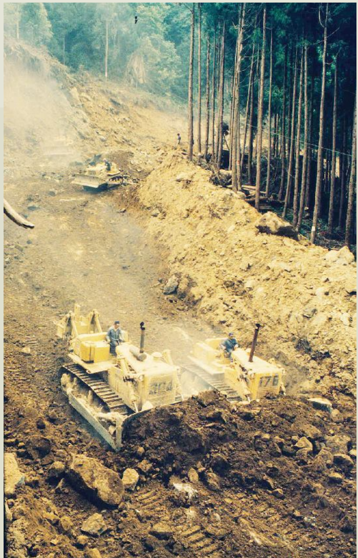
新中橫公路施工一景。
