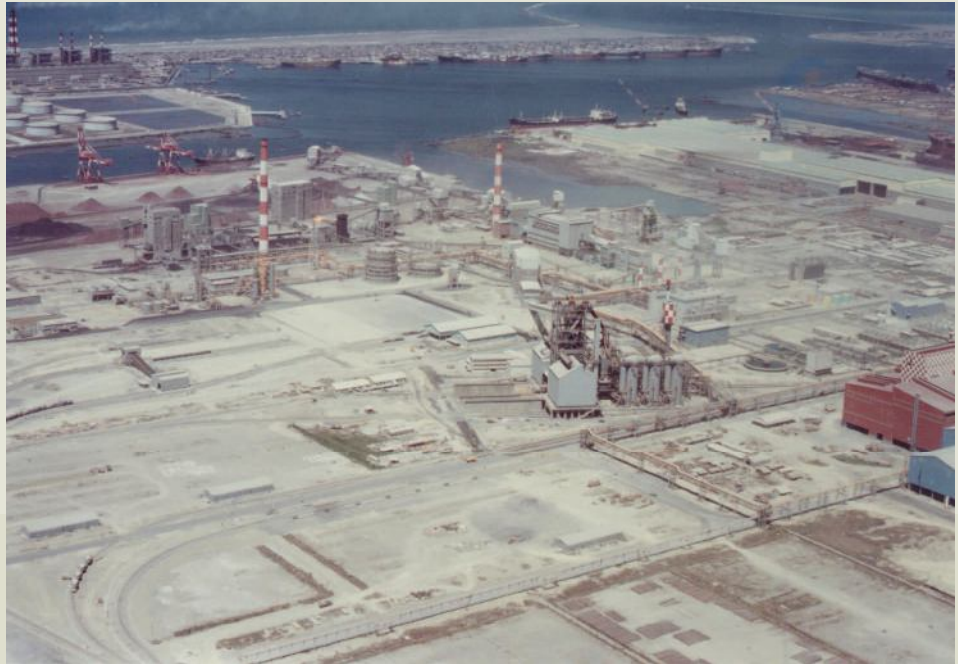
中鋼建廠工程變化萬端，為十大建設中另一特色。
