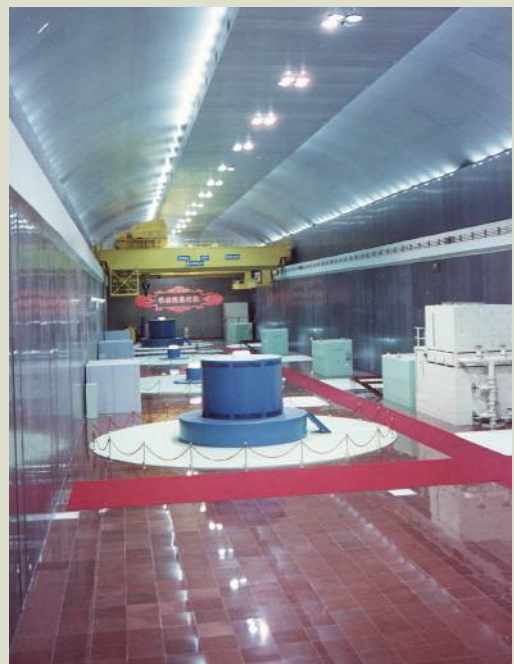
台電明湖抽蓄水力發電工程是榮工歷年承辦最艱鉅的地下工程之一。
