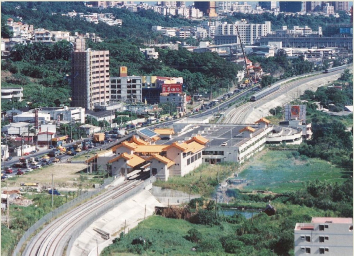
台北捷運淡水線紅樹林站及路堤。
