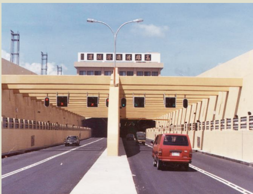
以沉埋管工法完成的高雄過港隧道，品質受到廣泛讚譽。
