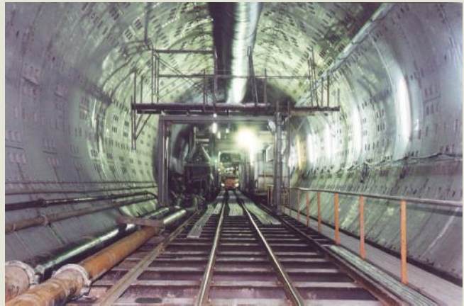
台電龍門計畫循環冷卻水出水道海底潛盾隧道。
