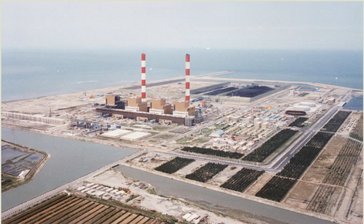
台中火力發電廠完工初期鳥瞰。
