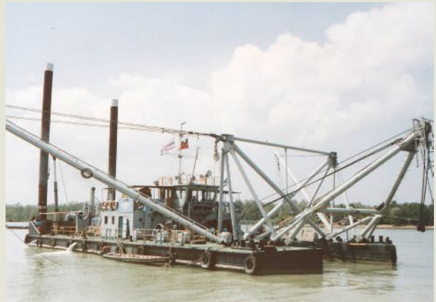
泰國南部北大年漁港挖泥工程。
