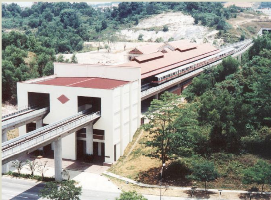
新加坡地鐵裕廊支線完工通車。
