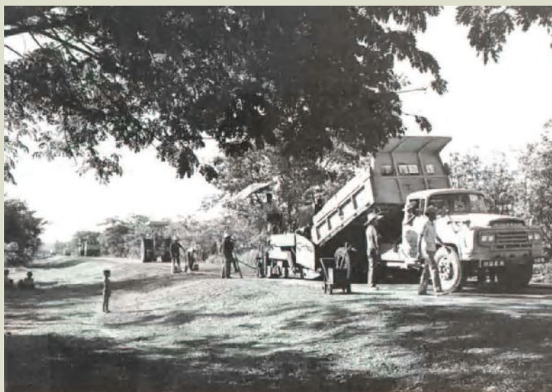
早期的泰國高級公路施工。
