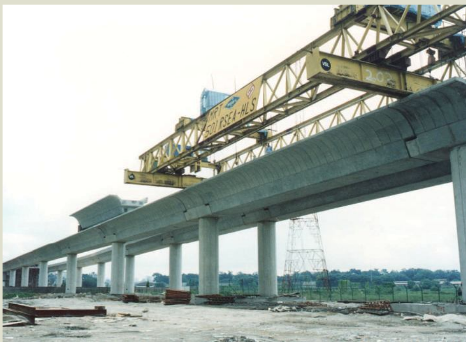
新加坡地鐵501標吊樑。
