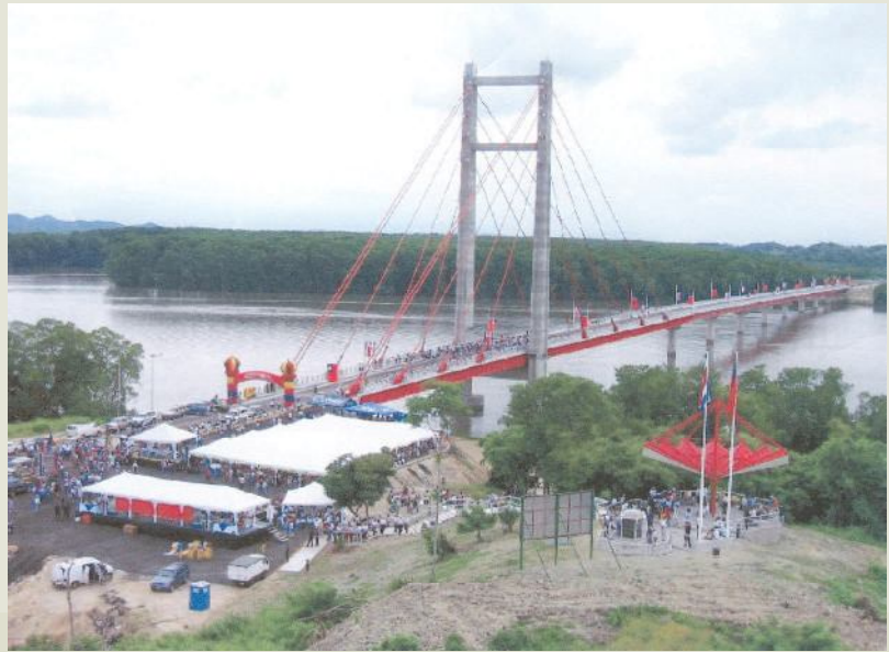
榮工公司在中南美哥斯大黎加完成的斜張橋—台灣友誼大橋完工通車。
