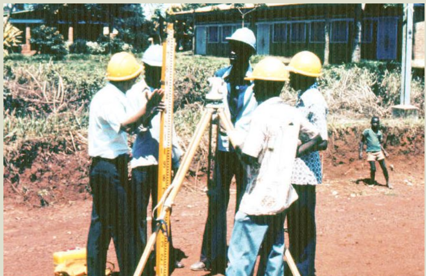
中非公路工程技術組指導當地技術人員進行測量作業。
