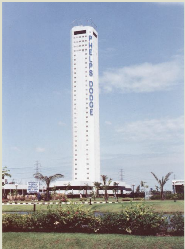
榮工完成的泰國挽披高塔。
