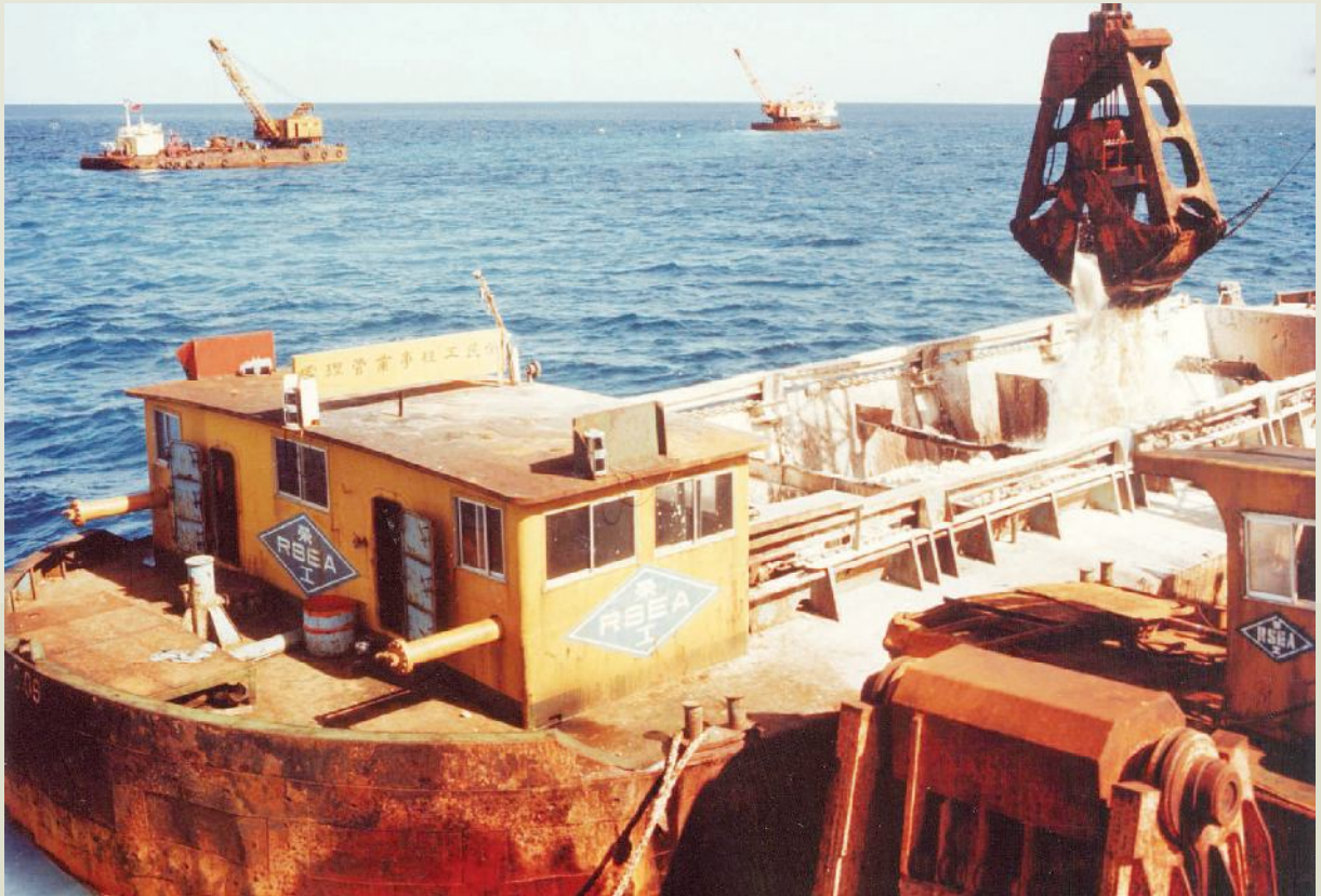
狄亞哥挖泥工程。
