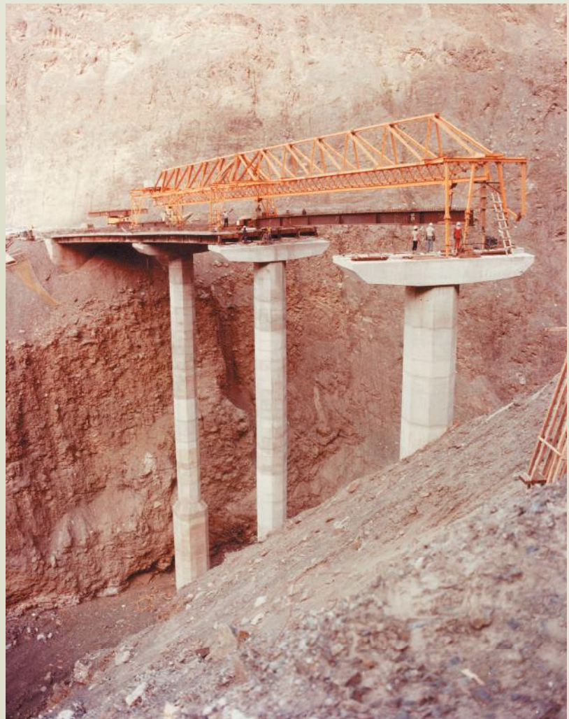
沙烏地夏爾降坡道路工程吊裝鋼樑，施工人員在懸崖山谷間作業，極其驚險。
