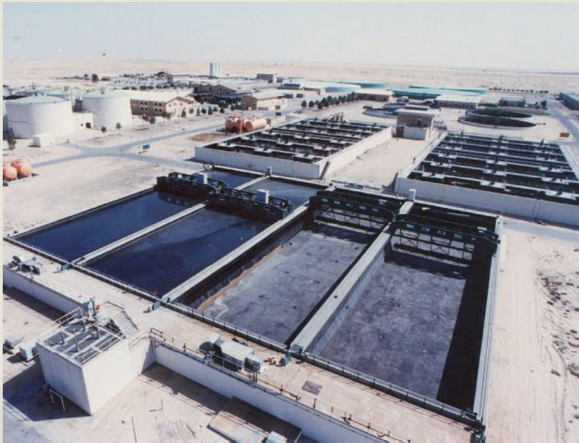
沙烏地朱拜污水廠工程。
