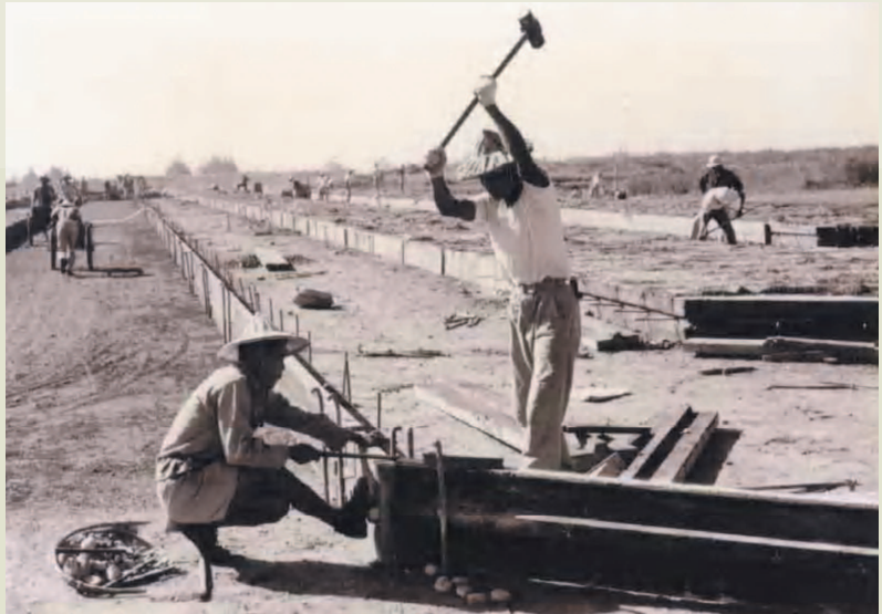
屏東機場工程的人力施工。
