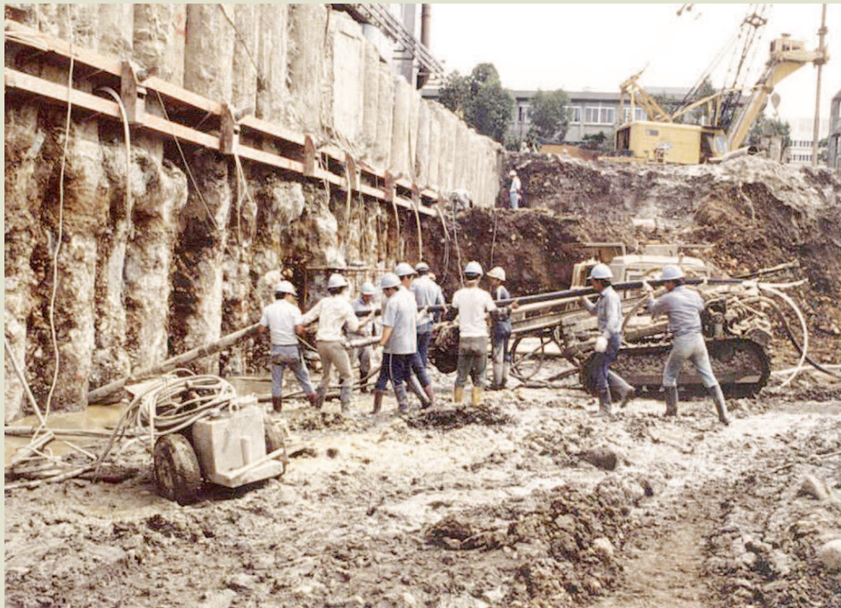
基礎工程隊的地錨施工。
