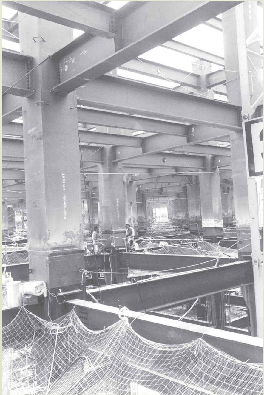
機電工程隊在台北榮總更新計畫工程的鋼構作業。
