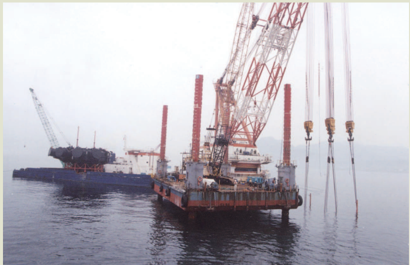
榮工承辦台電核四循環冷卻水出水道工程，啓用多項新工法，圖為排水頭J型管海上吊裝作業。
