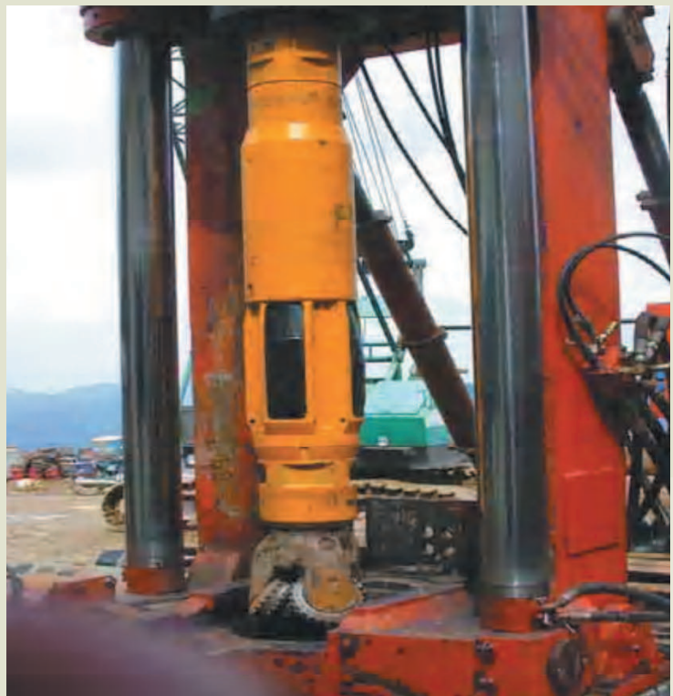
雪山隧道第1號豎井工程由榮工引進的昇井工法導向鑽孔系統。
