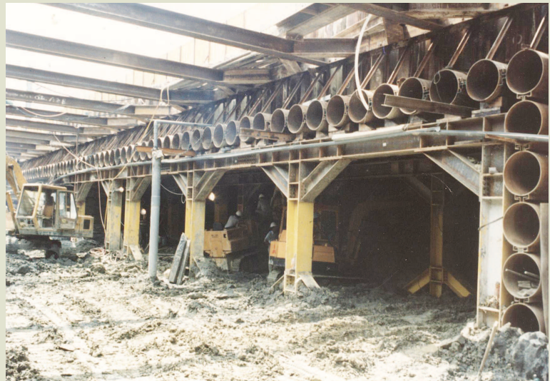
榮工引進、使用於高雄博愛地下道的管幕工法。
