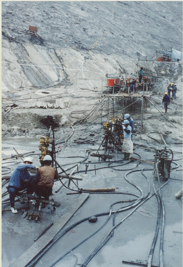
基礎工程隊的大壩壩基灌漿作業。
