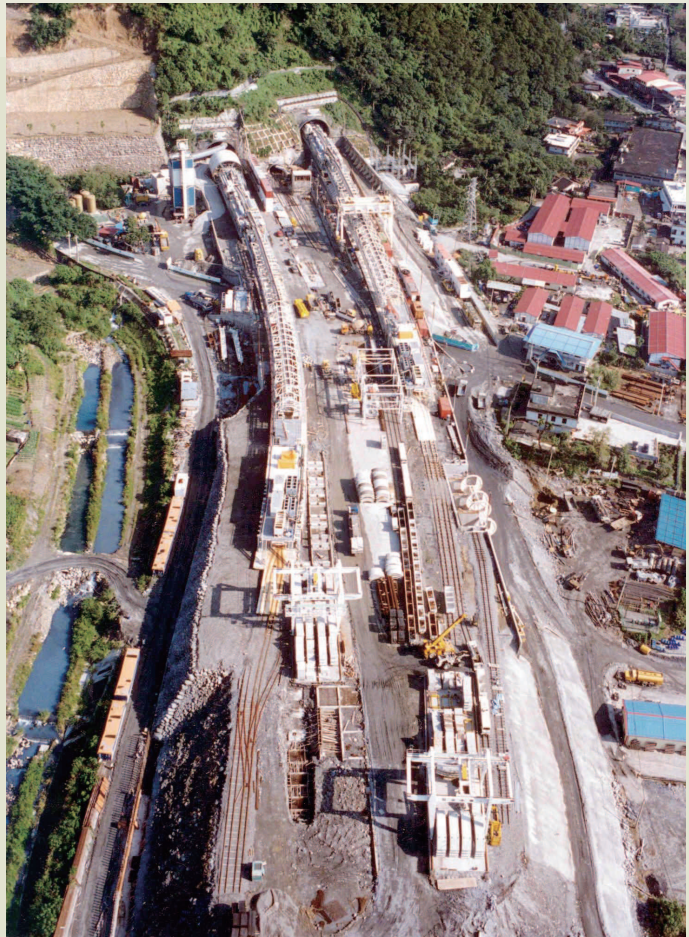
榮工引進隧道全斷面鑽掘 (TBM) 工法，進行雪山隧道施工。
