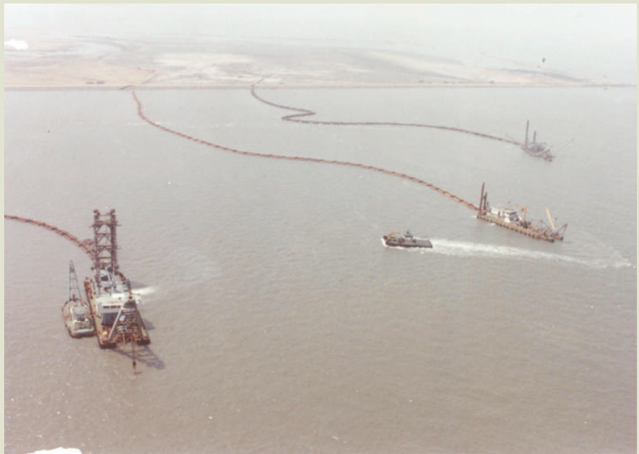
浚渫工程隊的挖泥船在彰濱工業區鹿港區進行抽砂填土作業。
