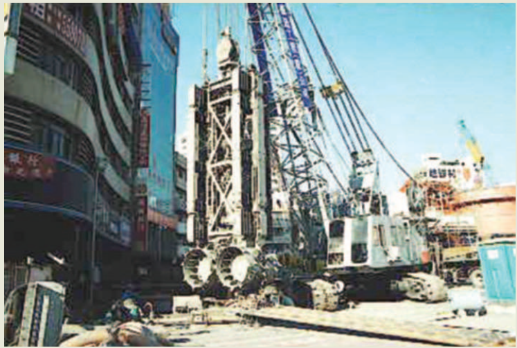
地下連續壁為榮工60年代引進之工法，上圖為榮工在高雄捷運首次以EMX-150鑽機做1.8公尺厚之地下連續壁。
