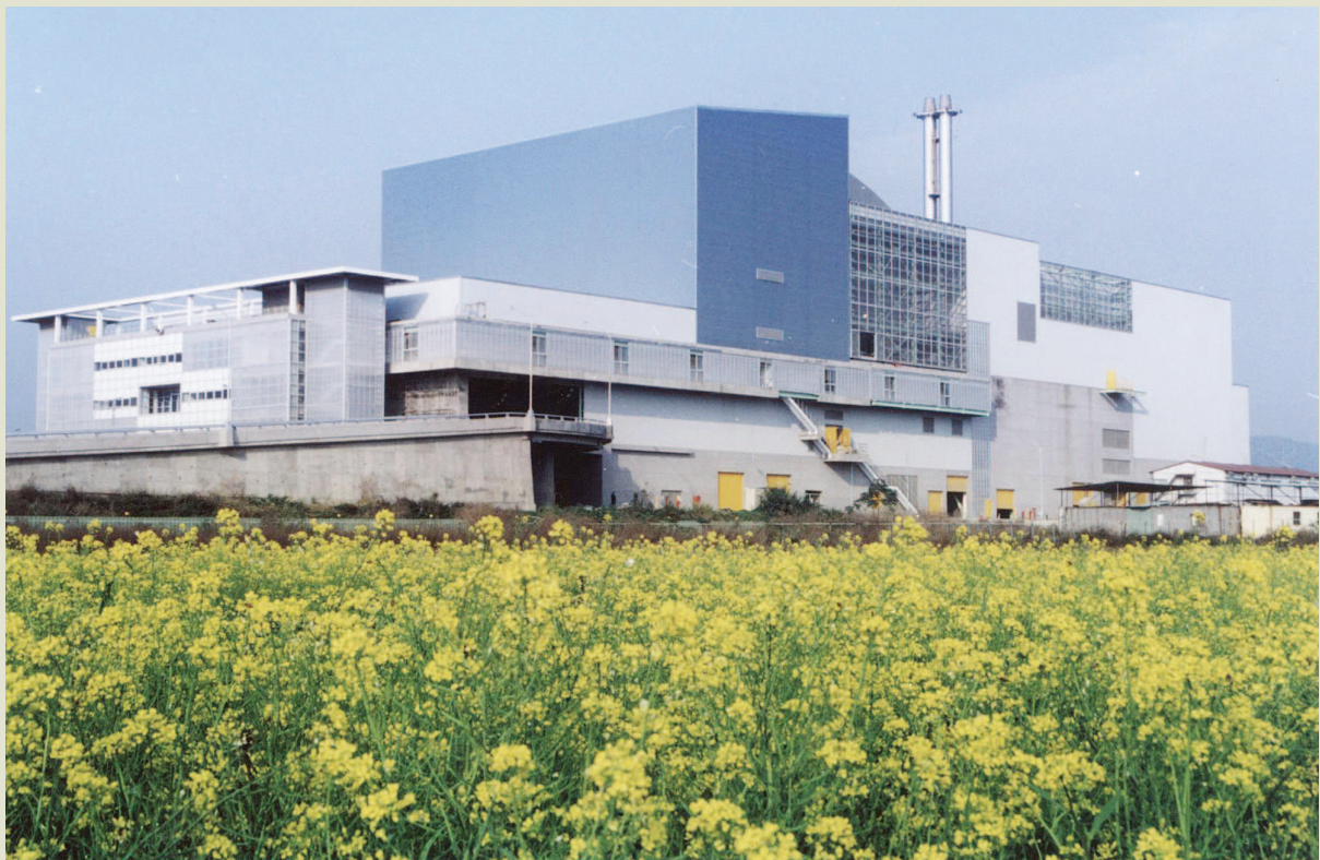
雲林縣焚化爐工程。
