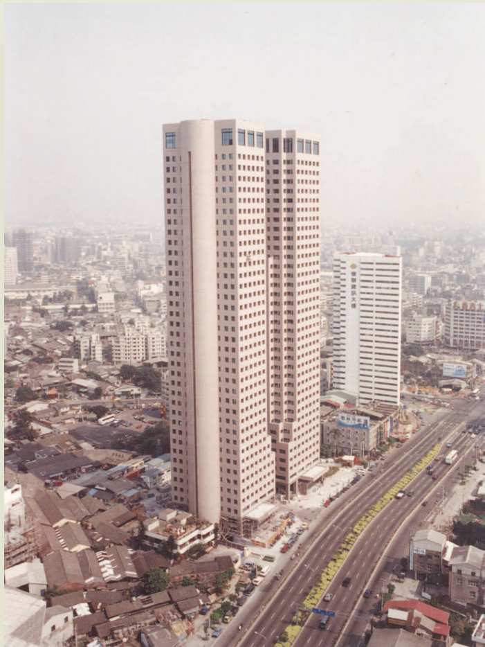
榮工完成外牆預鑄版製作吊裝的台中世貿雙星大樓。
