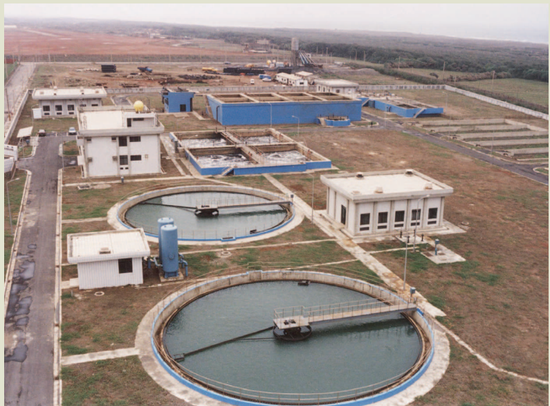
觀音工業區污水處理廠。
