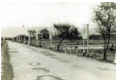
民國50年處區前的林森路兩側均為貯木池
