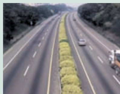
高速公路分隔島的植栽工程
