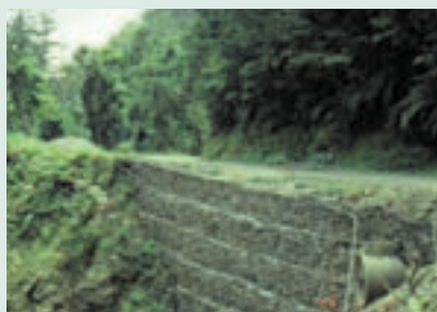
國土保安工作之一：林道邊坡的維護
