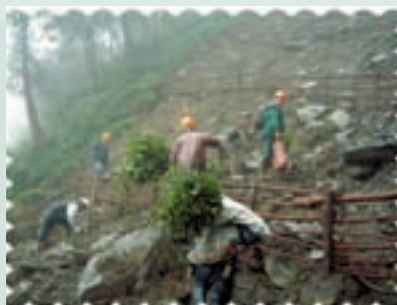
邊坡修護作業
