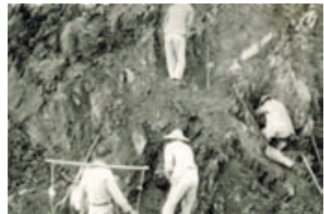
民國50年榮民開闢林道時的鑽岩情形（攝於棲蘭山林區）
