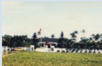
民國75年間壽豐場部景觀，可見15年間樹木成長情形及周邊景觀變化情形
