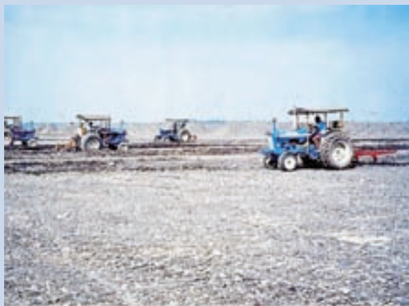
台糖花蓮河川地開發工程施作情形
