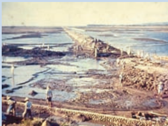
台南海埔地開發工程情形
