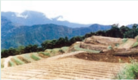
水土保持之平台階段（攝於民國74年）
