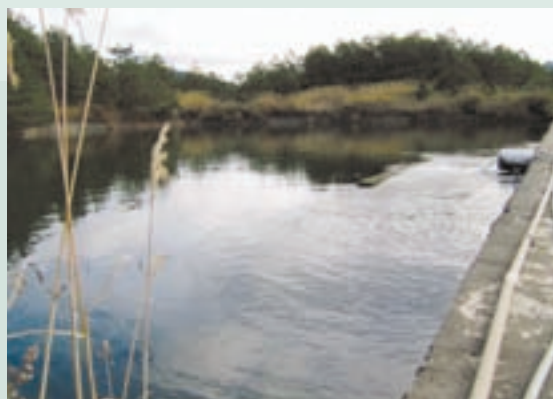
引自合歡山水源頭之儲水池（攝於民國75年）
