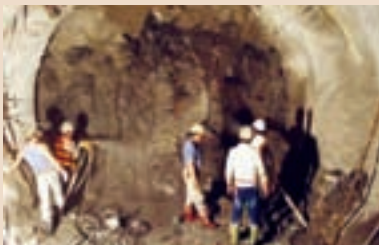
雪山隧道施工。
