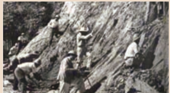
榮民用手、鐵鍬、鑽子等開闢中部橫貫公路。
