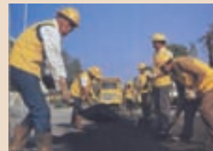
台北勞務中心道路工程。
