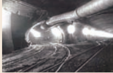
北迴鐵路隧道工程。
