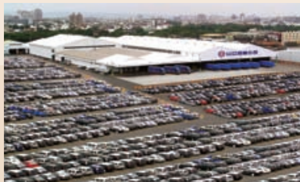
前桃園工廠以ROT促參案興建之大型綜合物流中心。
