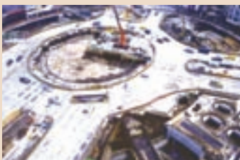
高雄市捷運大圓環車站工程。
