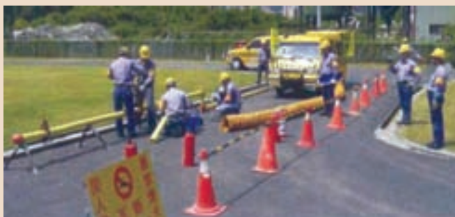
瓦斯管路漏氣搶修演練。
