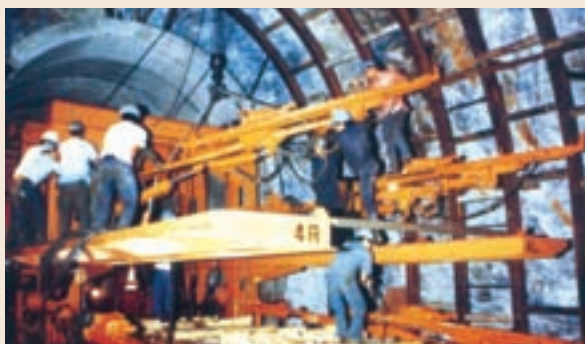
榮工處興建北迴鐵路隧道工程情形。
