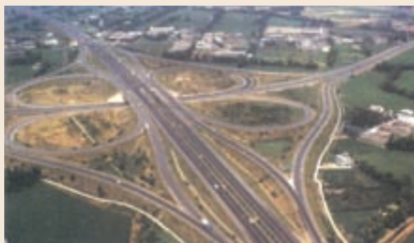
榮工處參與建設之中山高速公路工程。
