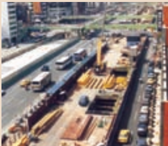
台北市捷運南港工程。
