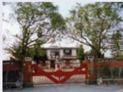
本處前身「聯絡中心」舊址 (51.10)
