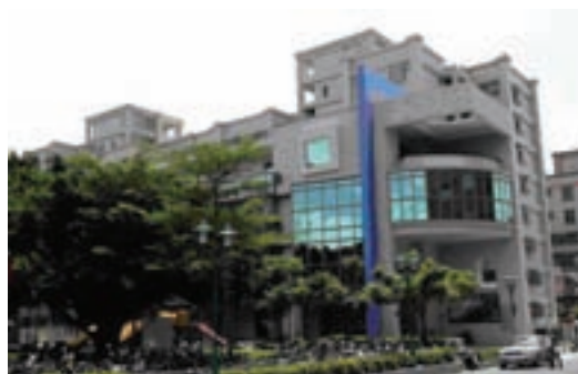
新建全新方位綜合辦公大樓（95.3）
