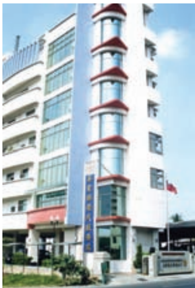
新建大樓完工（89.12.15）
