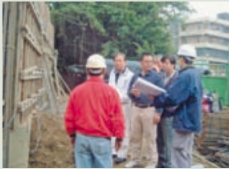
彭先生（中立者）工地現場督導
