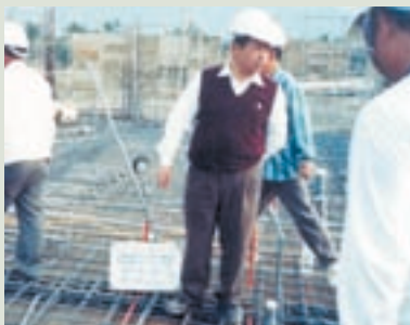
范組長（左）查驗工程施工作業
