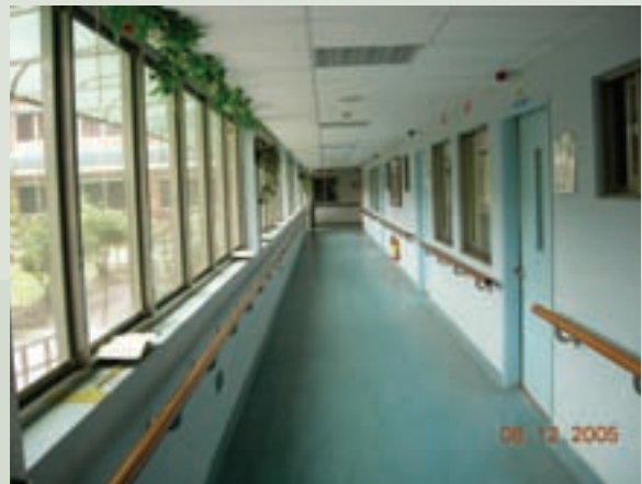
室內無障礙設施－扶手
