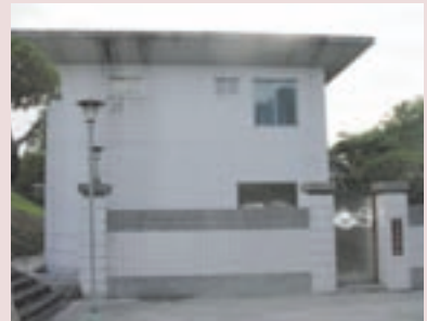
污水處理廠外貌
