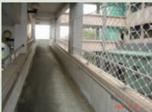
無障礙坡道加裝護欄
