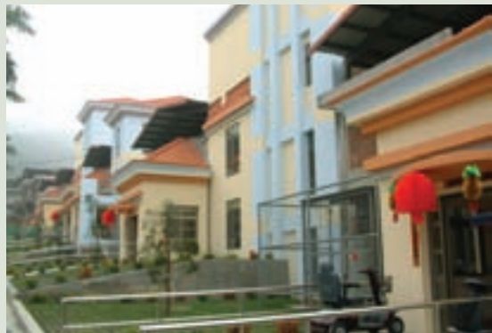
民國94年完成第1期修建之養護堂榮舍
