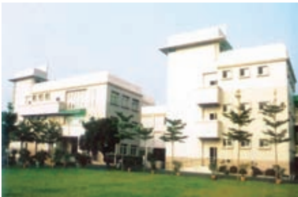
89年興建3棟3層（400床）養護大樓
