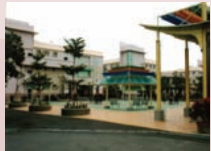
新建養護大樓及休閒廣場
