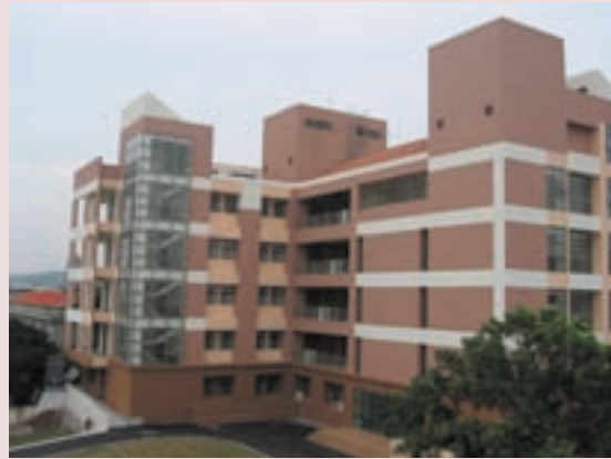
民國95年11月中程計畫第1棟榮舍完工啓用
