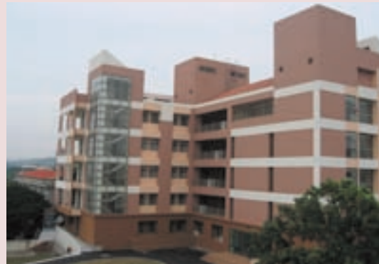
中正紀念堂拆除改建成安養大樓
