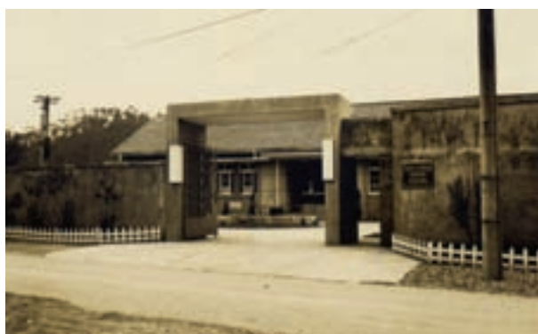
位於景美之榮民醫院聯合製藥廠廠區大門
