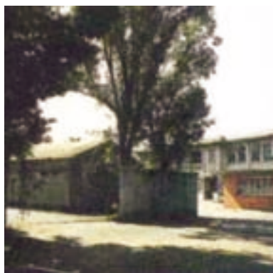
公館廠舊址－左側平房為借用國防醫學院之實習工廠
