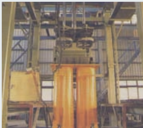
預鑄電纜管生產廠房及設備
