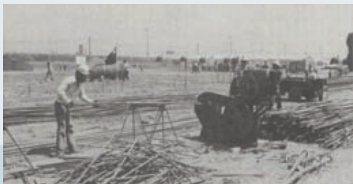
楠梓新廠工地初期開工情形（民國69年）
