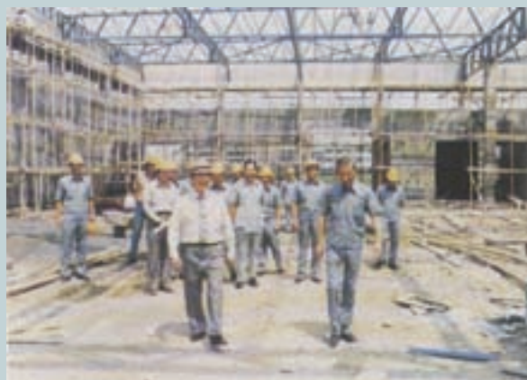
朱光鼎廠長（前右）陪同趙聚鈺主委（前左）巡視新建廠房工程（民國69年）
