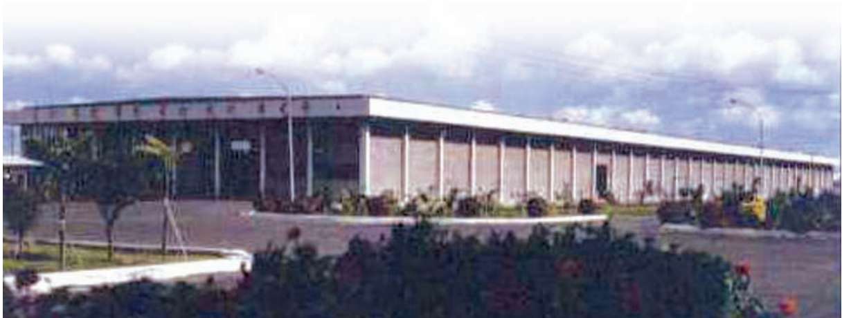
楠梓工廠砂紙布生產廠房外觀
