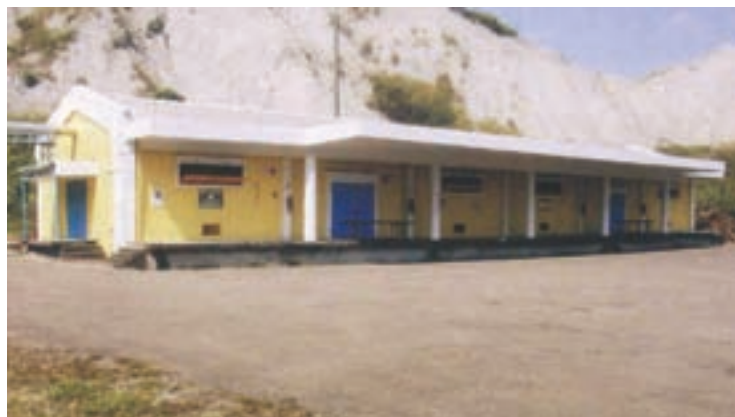
天然屏障良好之標準工礦炸藥庫儲設施
