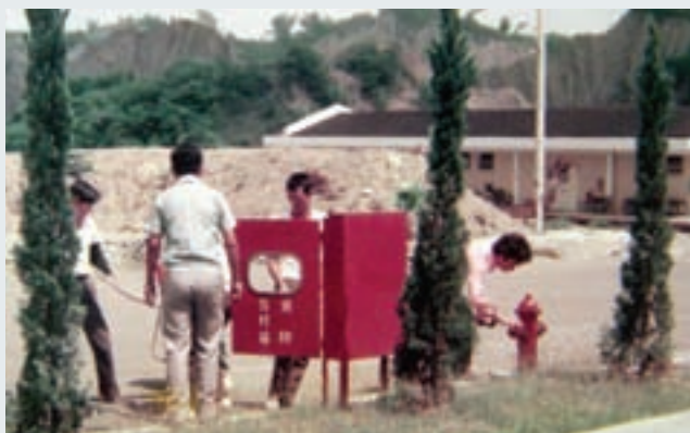
消防器材保養檢查
