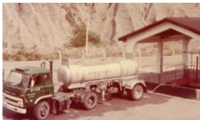
硝甘炸藥原料混酸槽車及儲酸池
