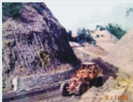
創建時興建廠區道路
