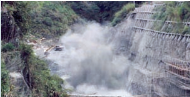
客戶榮工公司於工地使用工礦炸藥施作情形
