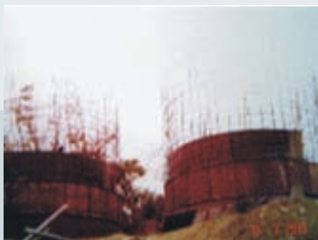
創建時興建廠區蓄水池
