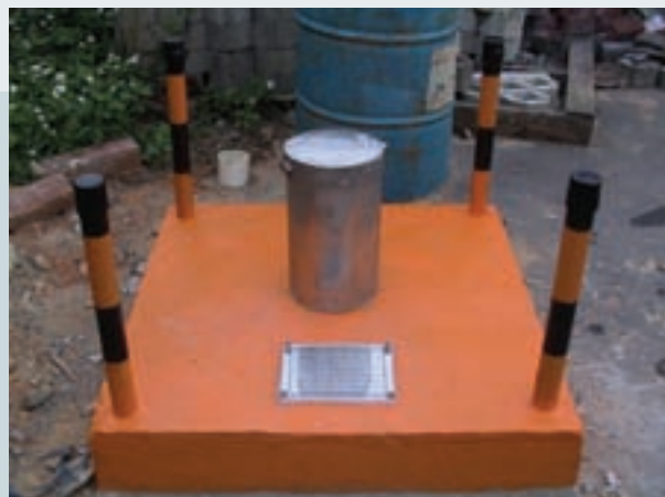
地下水監測井
