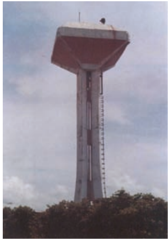
廠區及附近之地標—給水塔設施
