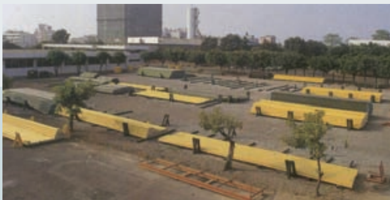
PE管產品露儲場
