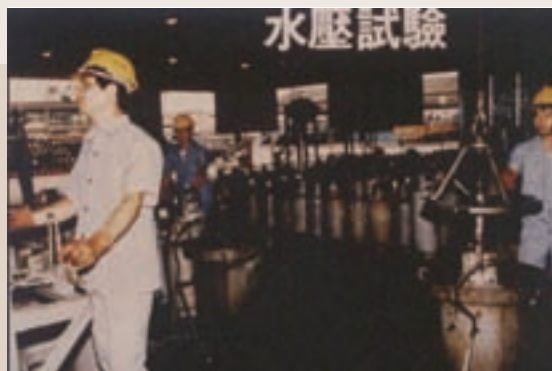
鋼瓶之水壓試驗
