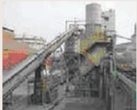
爐石處理設備
