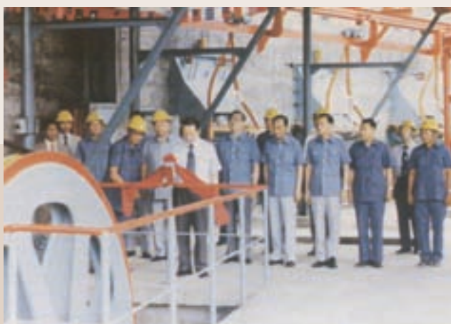
白雲石礦場完成趙聚鈺主委按鈕開工（民國66年）
