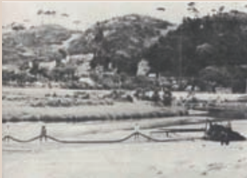
「金山砂礦場」架設水管作業(民國53年)
