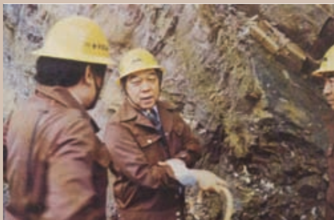
第五處處長劉慶生（中）視察清昌山道開發工程（民國65年）
