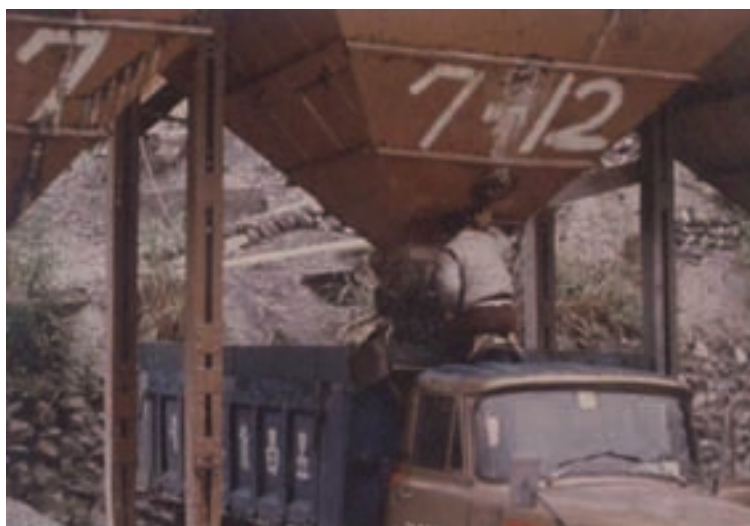
開採之石材運裝設備
