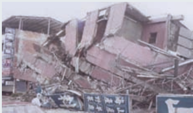
921大地震房屋倒塌
