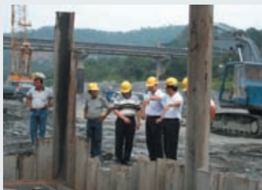
楊郁湜主任(右2)視導山地門橋樑工程
