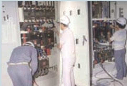
大樓配電工程
