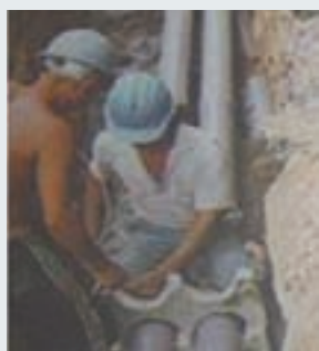
埋設台電電纜管
