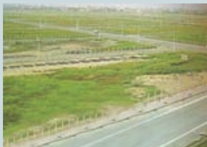
工業區路面整建
