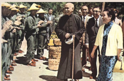
中部橫貫公路是由榮民弟兄流血流汗和犧牲生命建築完成的。圖為先總統蔣公（中）慰問工程人員辛勞的情形。
