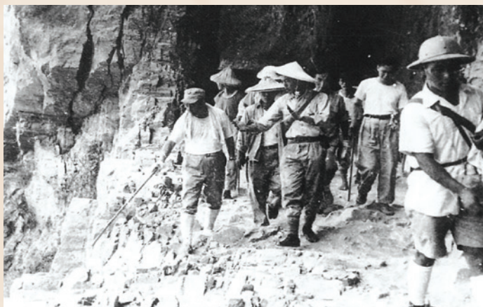
蔣主任委員（左1）巡視東西橫貫公路工程進度。
