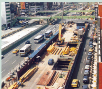
臺北市捷運南港工程。
