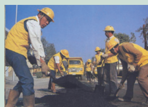
臺北勞務中心道路工程。
