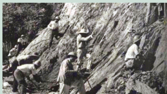
榮民用手、鐵鍬、鑽子等開闢中部橫貫公路。
