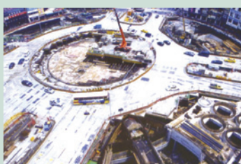
高雄市捷運大圓環車站工程。
