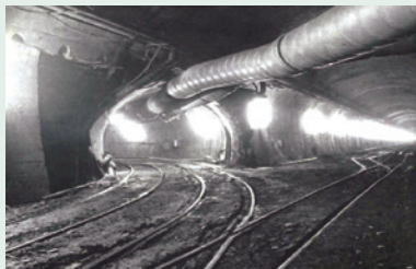
北迴鐵路隧道工程。
