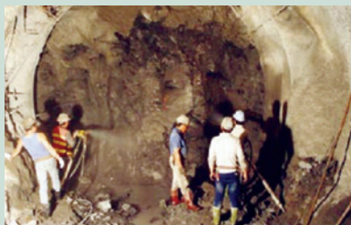
雪山隧道施工。
