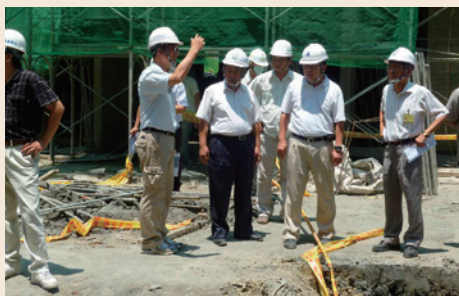
范副處長（左3）督導高雄榮總工程情形。
