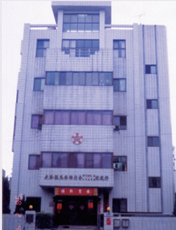
本處現址4、5樓的加蓋工程完成後留影。
