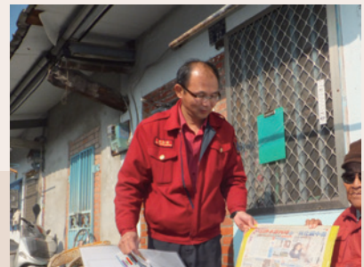
高危榮民居所電氣設備檢修（103.1）。
