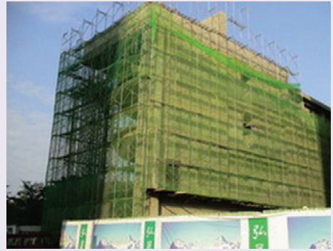
興建中綜合辦公大樓外貌（94.12）。
