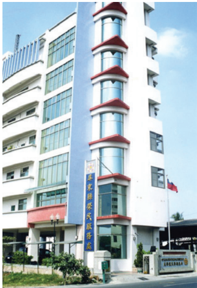
新建大樓完工（89.12.15）。
