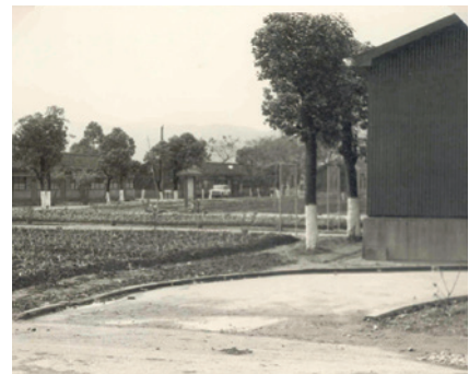
榮舍整建前實況。
