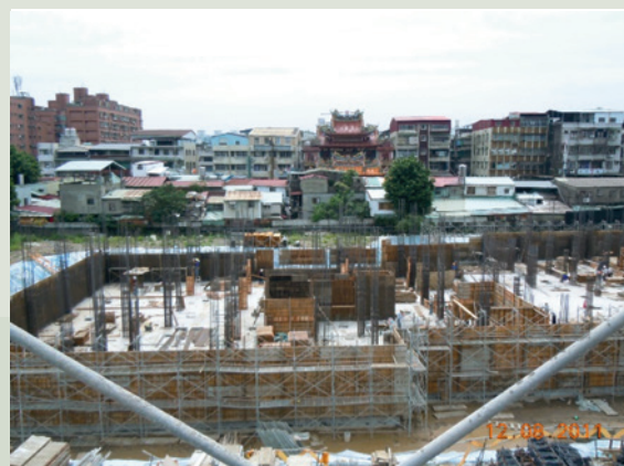
家區建造過程。
