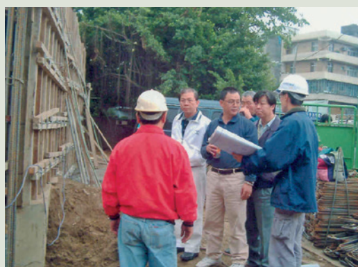
彭先生（中立者）工地現場督導。
