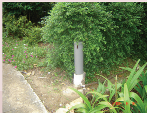
魚池周圍加裝紅外線警示器。
