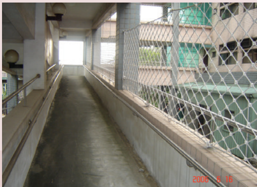
無障礙坡道加裝護欄。
