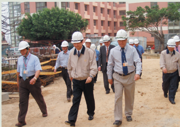
胡前主任委員鎮埔（前排中立者）巡視中程計畫榮舍施工。
