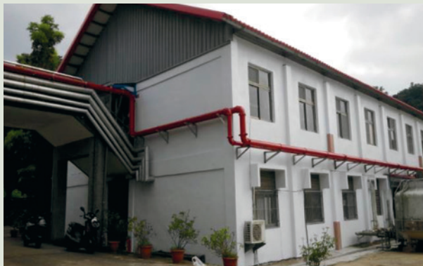
榮民安養中心長青樓。
