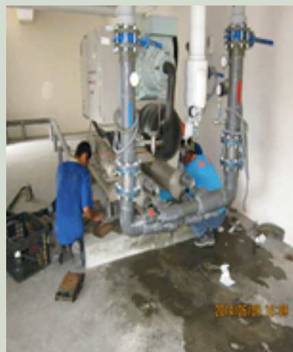
空調主機安裝情形。
