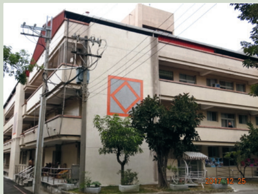
長春堂結構補強工程完工現況圖。
