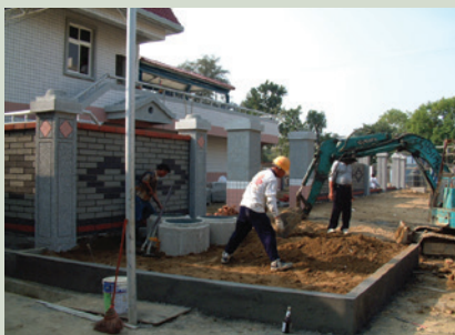
汙水處理場門前景觀工程施工。
