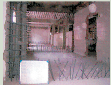
仁愛堂二樓剪力牆植筋。
