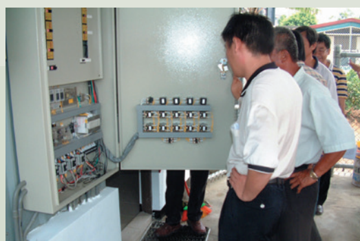
給水管路更新，配電盤驗收。
