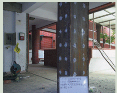
仁愛堂二樓柱鋼板補強封口。
