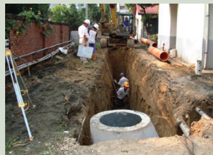
汙水處理場汙水管路開挖埋設。
