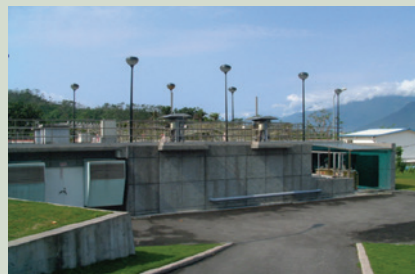
家區衛生下水道及污水處理廠近照。
