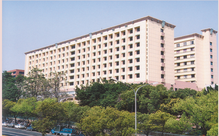
臺中榮總第一醫療大樓於民國91年整修後，外貌新穎時髦，煥然一新。
