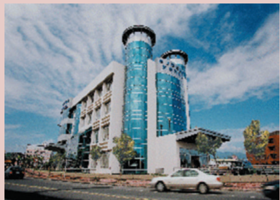
市區門診部91年11月完工。
