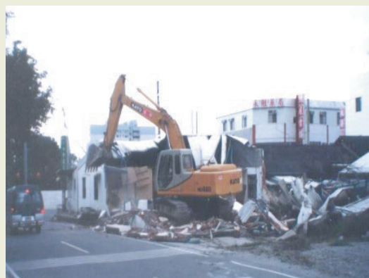
停車場、資源回收屋進行施工。
