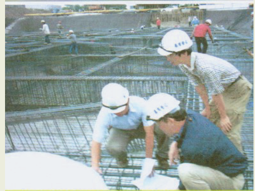
徐弘院長（左1）至工地瞭解工程進度。
