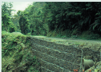
國土保安工作之一：林道邊坡的維護。
