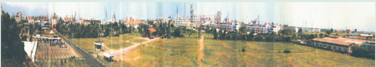
位於宜蘭市後火車站正面，森保處21公頃的土地。
