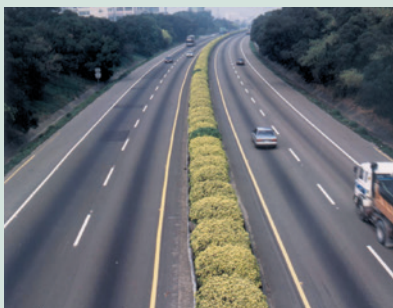
高速公路分隔島的植栽工程。
