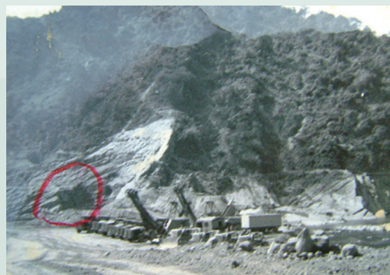
民國60年水庫施工情形（圈紅處為爆炸開鑿點）。
