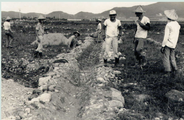
我榮民袍澤在石頭地上，以人力手工開闢灌溉溝渠作業情形，遠景即是海岸山脈。
